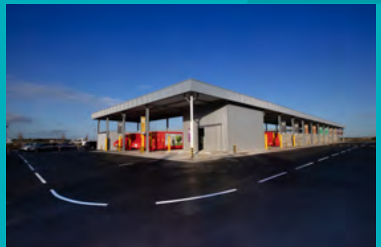
La nouvelle déchetterie construite en 2019 pour favoriser le tri et la valorisation des déchets
