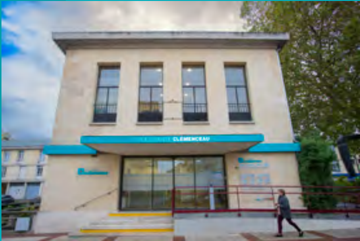
Le Pôle santé Clémenceau ouvert en 2014 pour préserver l'offre de soins en centre-ville
