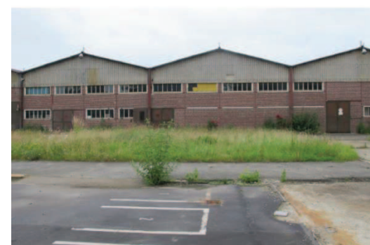
Ancienne usine Bosch en cours de démolition
