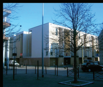
L'opération de renouvellement urbain re-crée un îlot.
