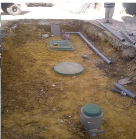
Photo 2 : installation après remblaiement
