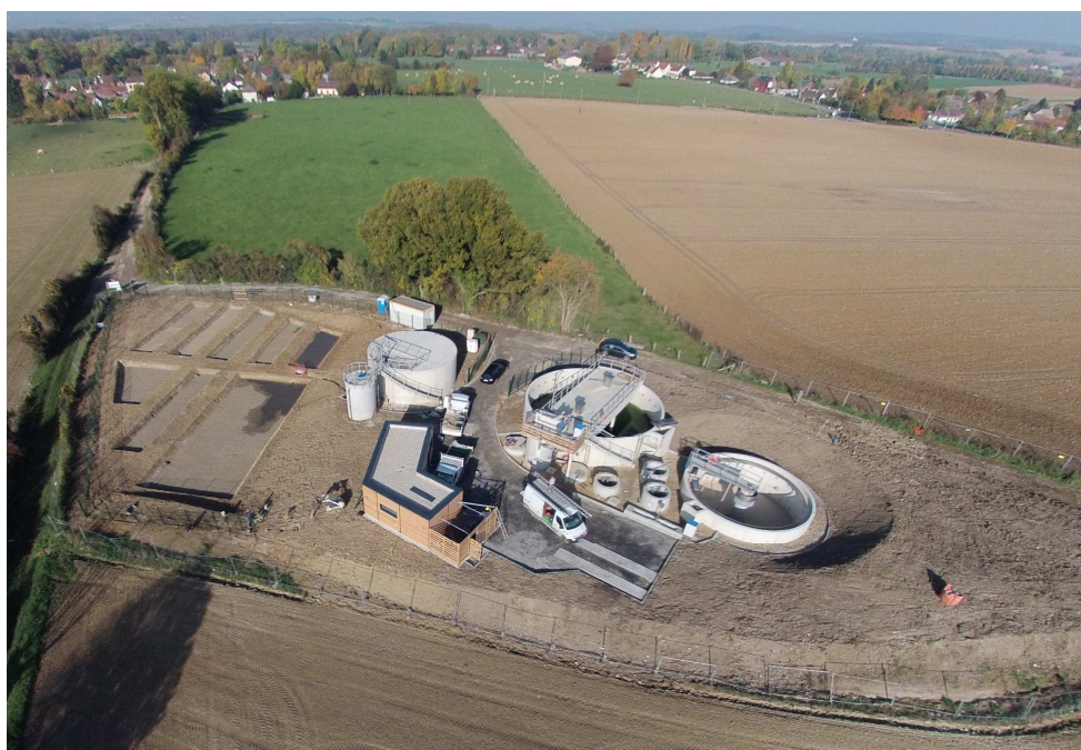
Photo 2 : chantier de la station d'épuration d'AUTEUIL (Constructeurs HYDREA/ZUB/AMODIAG/BELLIERE MANIERE)
