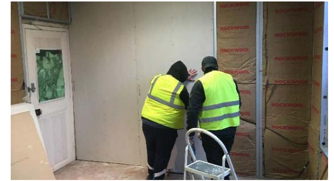
Réfection de bureaux en mairie - CI Bâtiment Nature
