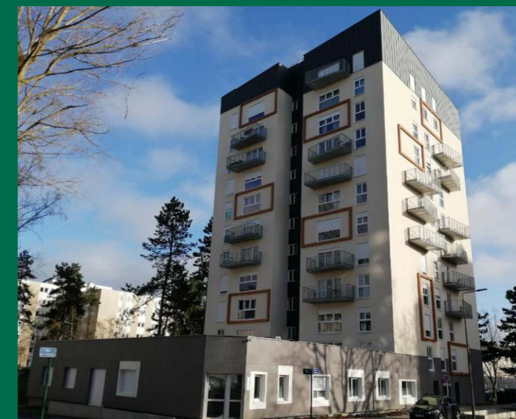
Tour A5 réhabilité - Argentine
