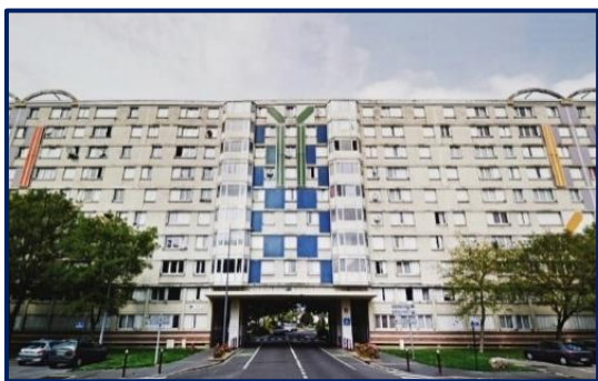
Bât B. Vue de l'Avenue de l'Europe.
