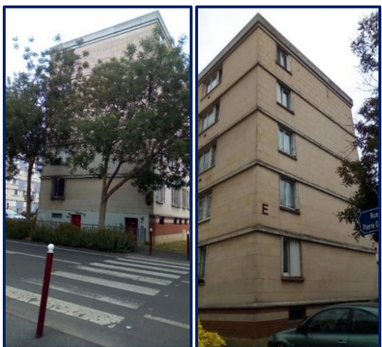
Bâts E et H. Vues sur le côté
