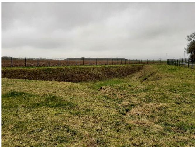
Figure 65 – Ouvrage d'infiltration O1\_19 en bordure de la RD149
