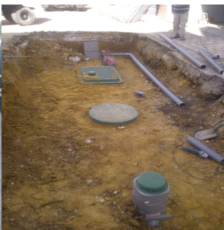
Photo 2 : installation après remblaiement
