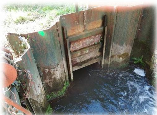
Figure 11 : Surverse en rive droite et buses des fossés aval
