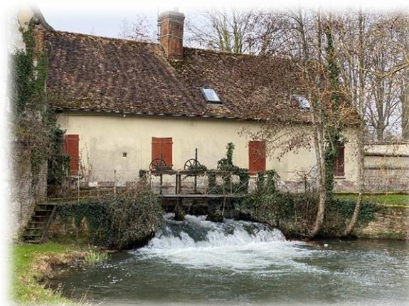
Figure 52 : Vannage du bief rive gauche
