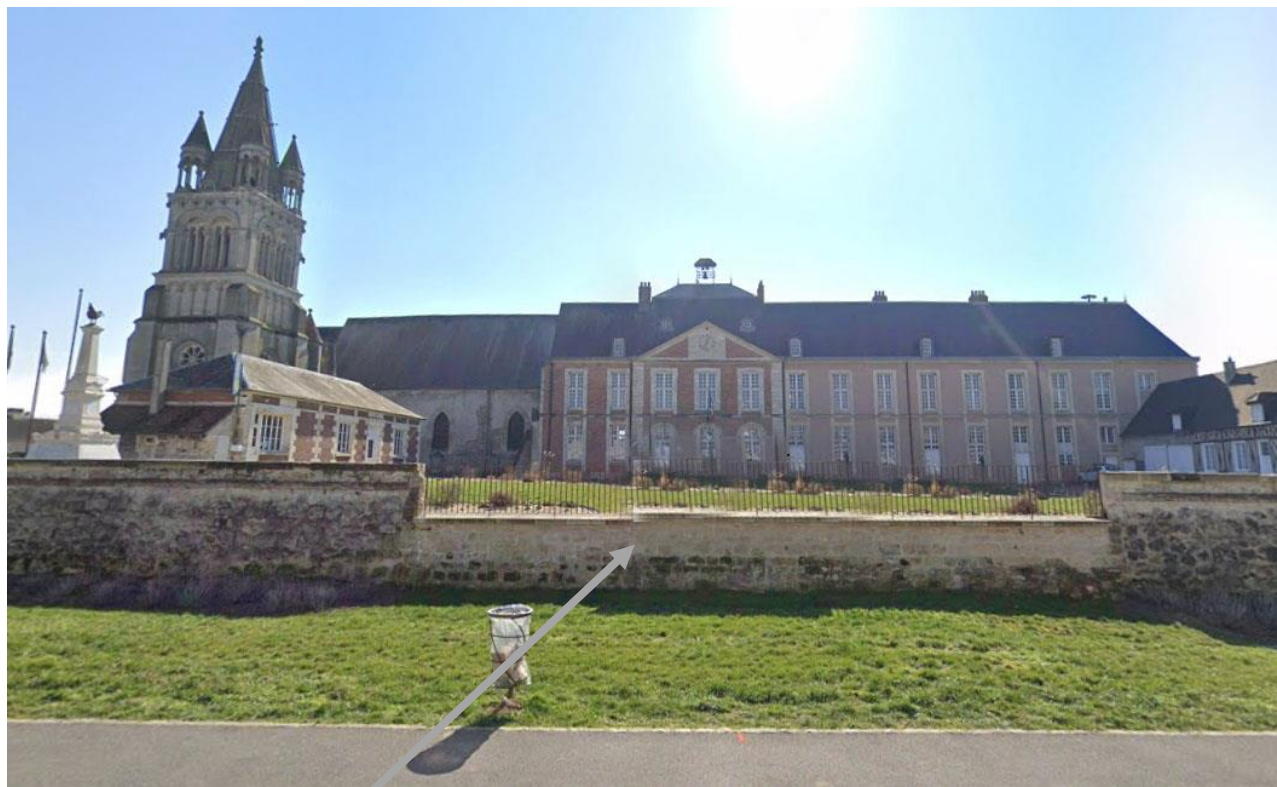
Emplacement de l’escalier double
