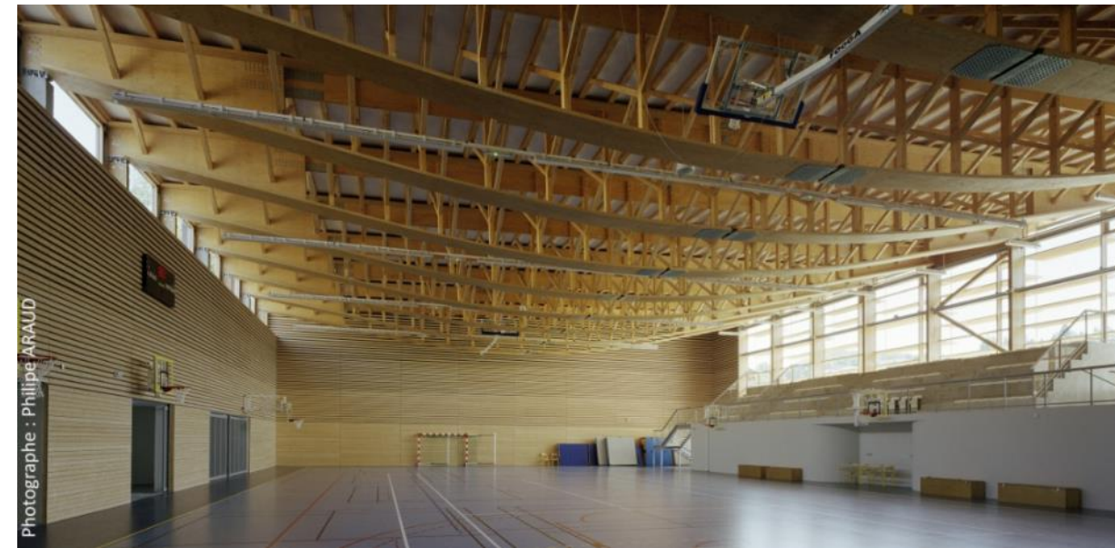
Gymnase 24x24 m bioclimatique, Saint-Martin-en-Haut (69) : bâtiment basse consommation 2012 1 747 m 2 SHON / 1 522 m 2 SU - 2 621 000 € HT Crédit photos : Renaud Araud Source : www.caue-observatoire.fr
