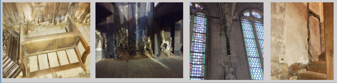
Infiltration d’eau depuis la toiture
