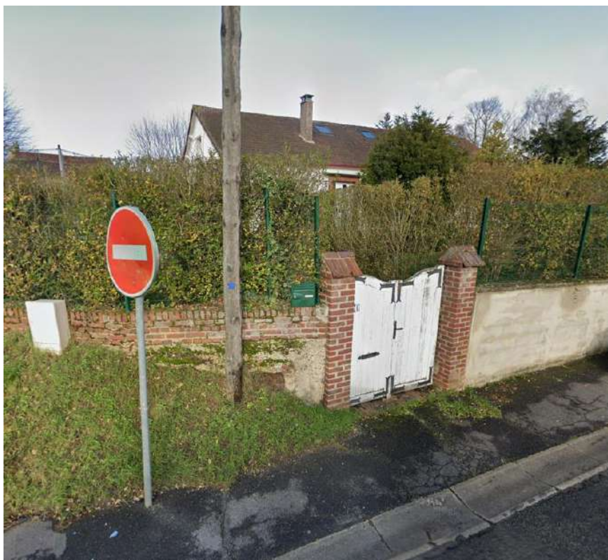
Figure 3 : Portillon d'accès à proximité de l'axe d'écoulement
