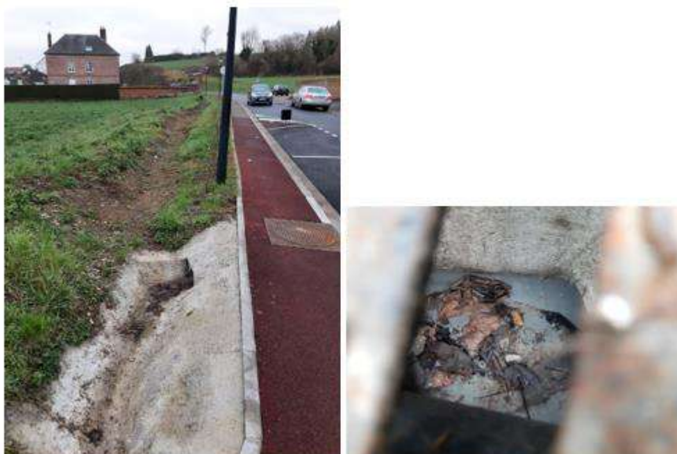
Figure 2 : vue sur le fossé bordant la parcelle et le comblement du réseau lors des investigations de terrain (janvier 2022)
