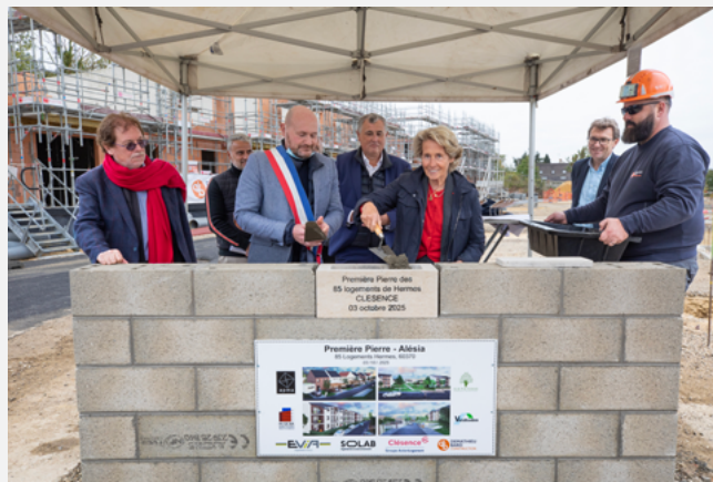
Pose de la 1 re pierre, à Hermes, du programme de démolition-reconstruction de la Cité Alesia par le bailleur Clésence. 30 logements, datant des années 60, ont été déconstruits pour laisser place à 57 logements qui répondront à des enjeux de transition énergétique, d'intégration dans le paysage, de connexion urbanistique, de confort des locataires.
