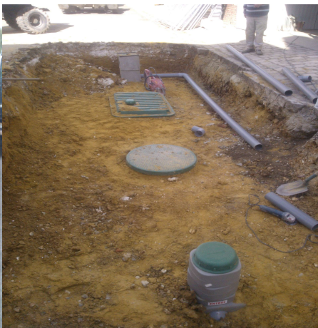
Photo 2 : installation après remblaiement
