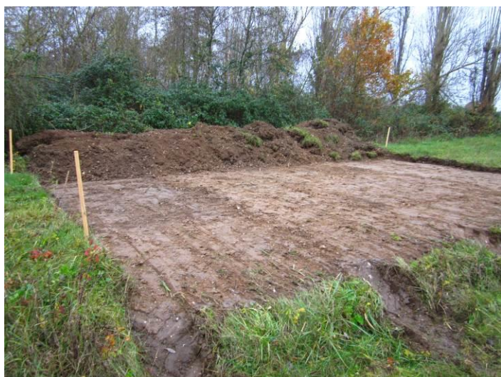
Exemple de décapage d'une zone d'accueil avec stockage des terres décapées © Thévenin OGE
