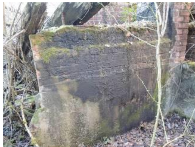
Murs tâchés – secteur nord (Source : ICF Environnement, mars 2015)
