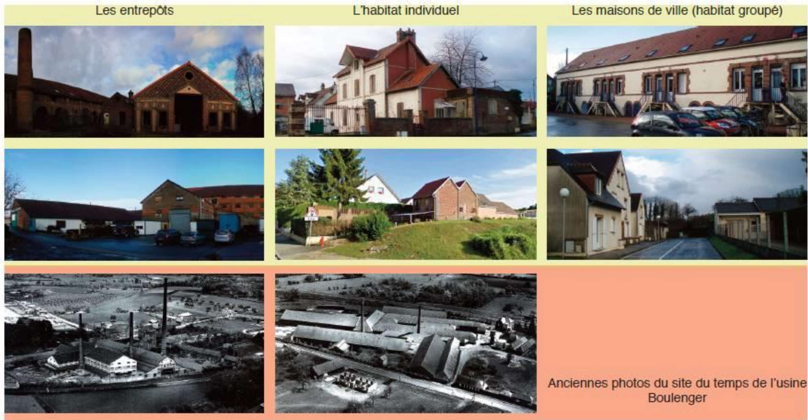
Les principales typologies de bâtiments (photographies) (Source : CAB)
