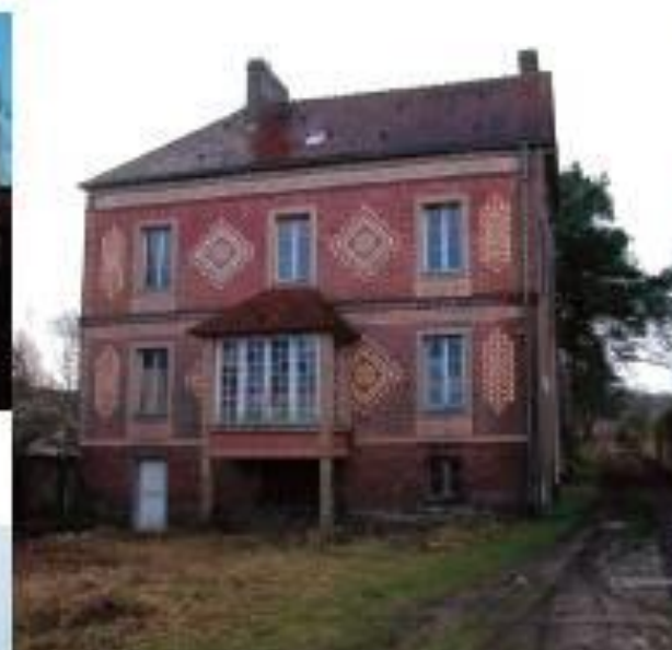
Maison de direction du site Boulenger
