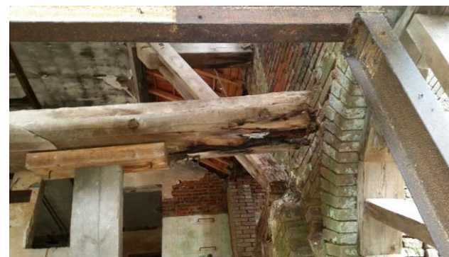
Structure porteuse menaçant de tomber (Source : BETOM, mars 2015)
