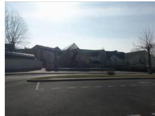
Collège du point du Jour, rue du Bel-Air (Source : A. SOKIL, MEDIATERRE Conseil, mars 2015)
