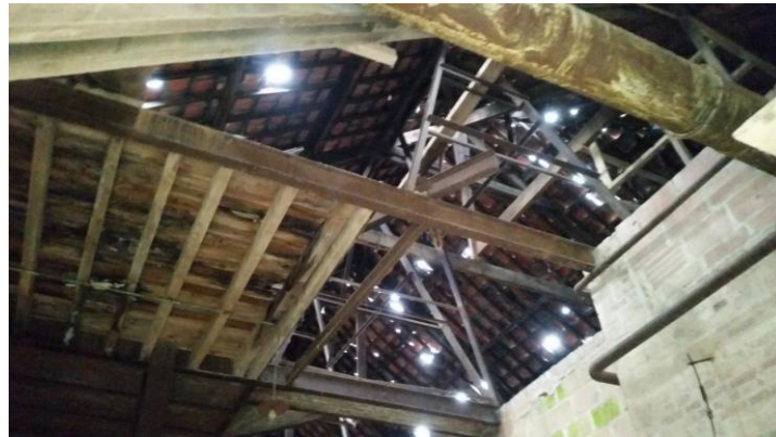
Charpente avec trous (Source : BETOM, mars 2015)
