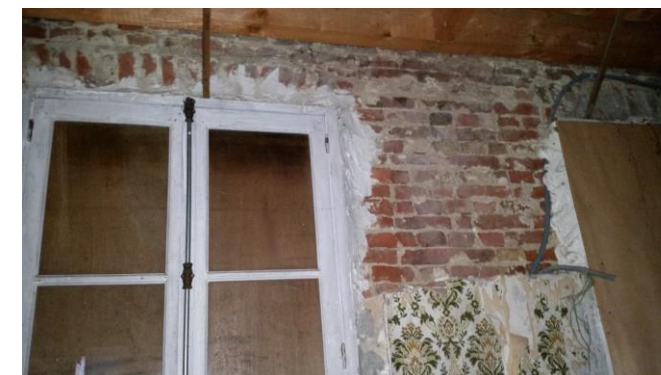
Murs et enduits du rez-de-chaussée en mauvais état (Source : BETOM, mars 2015)
