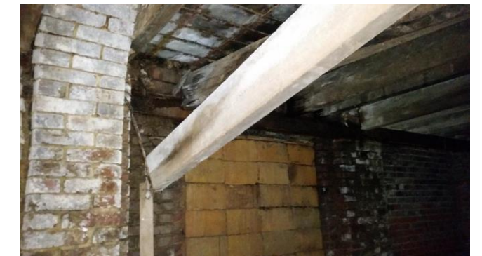
Assemblage de poutres pour maintenir le plancher du 1 er étage (Source : BETOM, mars 2015)
