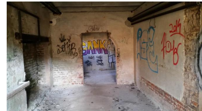
Murs tagués au rez-de-chaussée (Source : BETOM, mars 2015)
