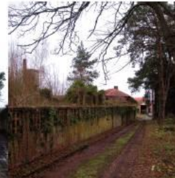
Mur de soutènement
