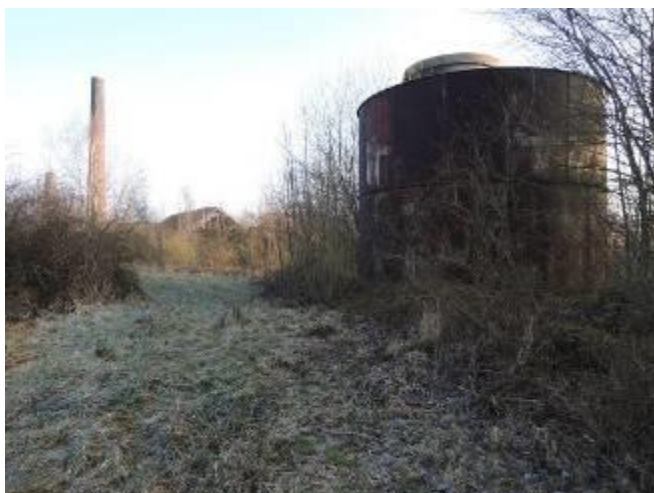
Cuve aérienne – secteur nord (Source : ICF Environnement, mars 2015)
