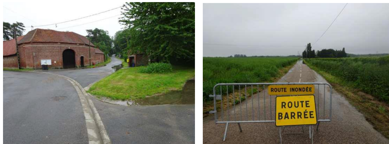
Carrefour de Sinancourt et rue du Bocteau après les inondations du mois de Juin 2016 (LaSalle Beauvais)
