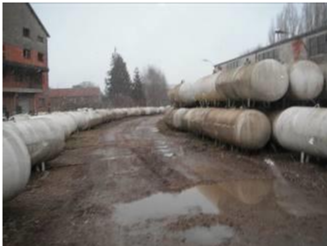
Stockage extérieur de cuves de gaz – secteur sud (Source : ICF Environnement, mars 2015)
