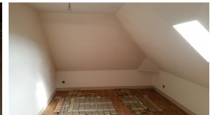
Combles en bon état général (Source : BETOM, mars 2015)
