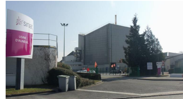
Usine SINIAT dans la zone industrielle de Sinancourt (Source : Anaïs SOKIL, MEDIATERRE Conseil, mars 2015)
