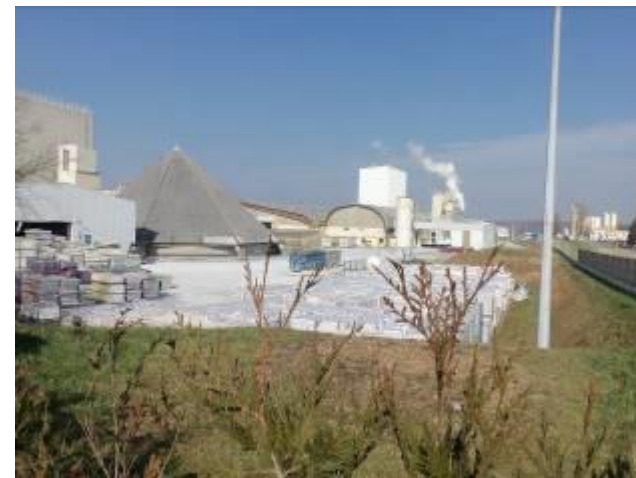
Zone industrielle de Sinancourt (Source : A. SOKIL, MEDIATERRE Conseil, mars 2015)
