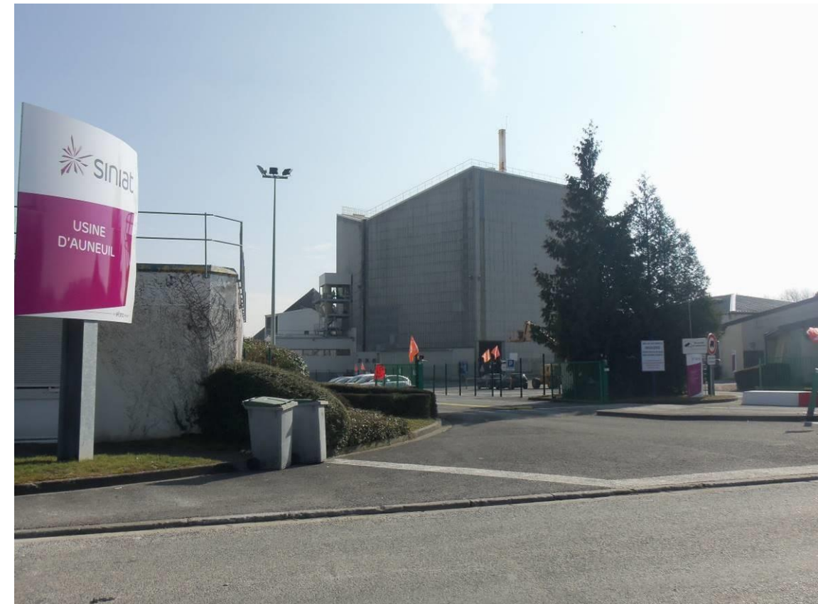
Usine SINIAT dans la zone industrielle de Sinancourt (Source : Anaïs SOKIL, MEDIATERRE Conseil, mars 2015)
