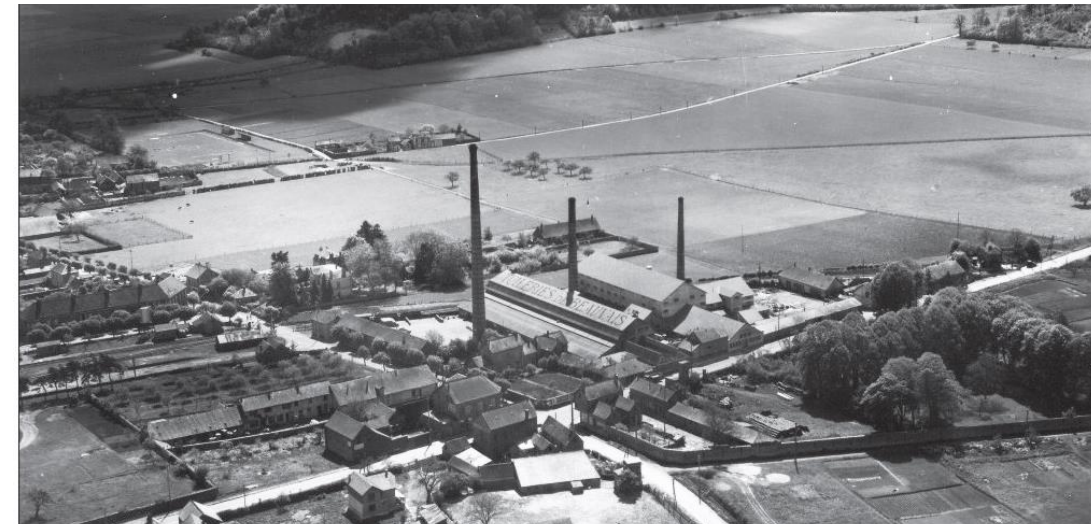
Vue aérienne du site, au niveau du secteur des Tuileries (Tandem +)
