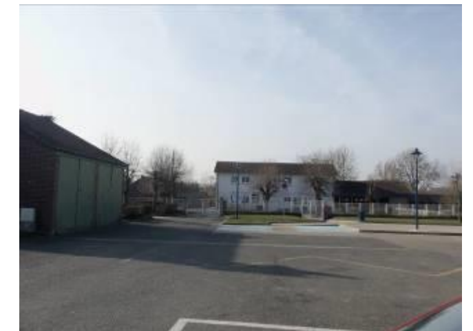
École élémentaire du Vieux lavoir, rue de la Place (Source : A. SOKIL, MEDIATERRE Conseil, mars 2015)
