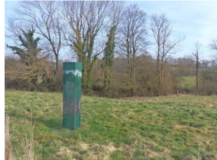
Station de pompage en bordure ouest de l'aire d'étude (Source : Anaïs SOKIL, MEDIATERRE Conseil, mars 2015)
