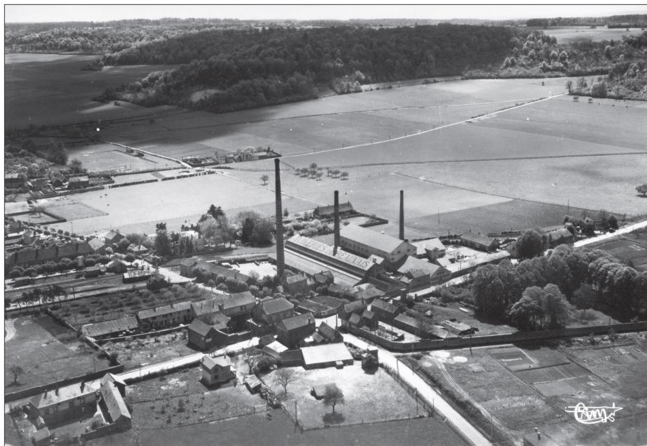
Vue aérienne du site, au niveau du secteur des Tuileries (Tandem +)
