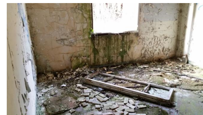
Murs des locaux à l'entrée du Magasin (Source : BETOM, mars 2015)
