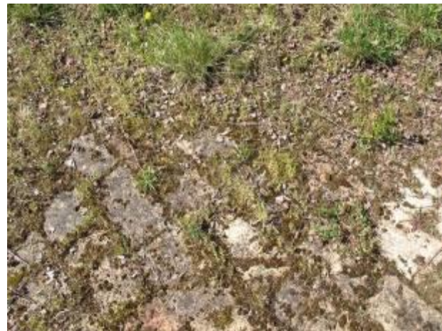
Revêtement de sol végétalisé, végétation thermophile à annuelles © BM – O.G.E.
