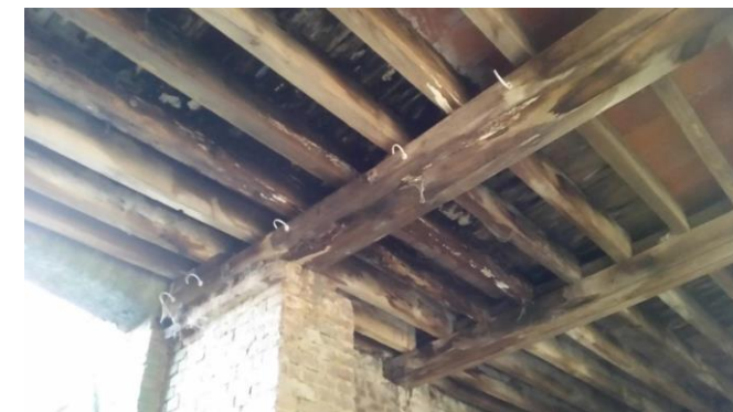
Plancher haut du rez-de-chaussée (Source : BETOM, mars 2015)
