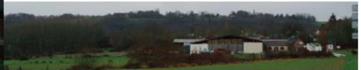
Depuis la D 981 au nord, les cheminées d'usine se devinent derrière le talus largement enrichi de la voie ferrée
