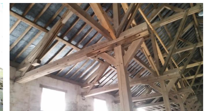
Charpentes (Source : BETOM, mars 2015)
