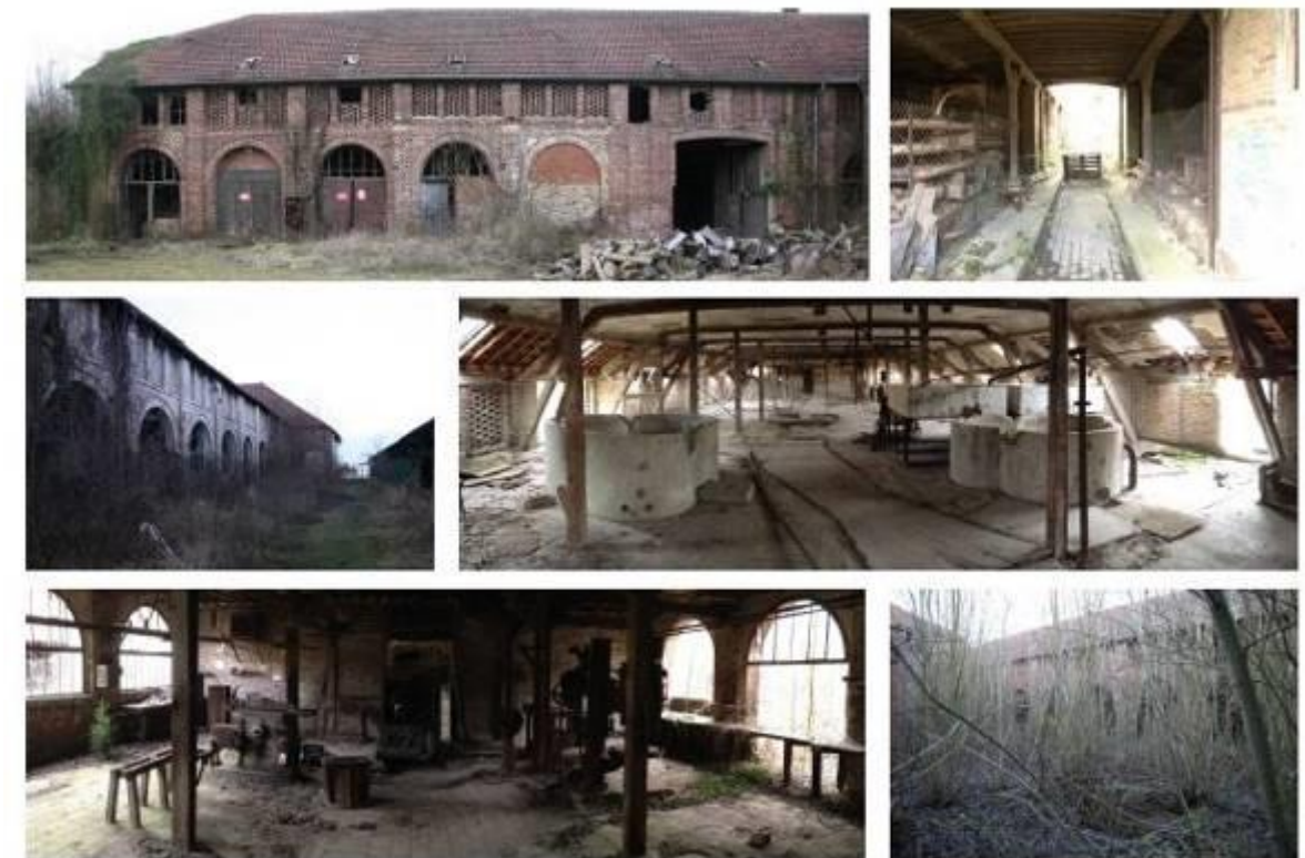
Photographies du bâtiment d'exploitation (Source : Tandem +)
