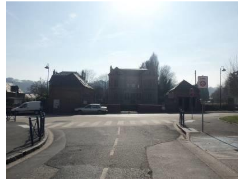
Bâtiment dit « Musée » vu depuis la rue de la gare (Source : A. SOKIL, MEDIATERRE Conseil, mars 2015)
