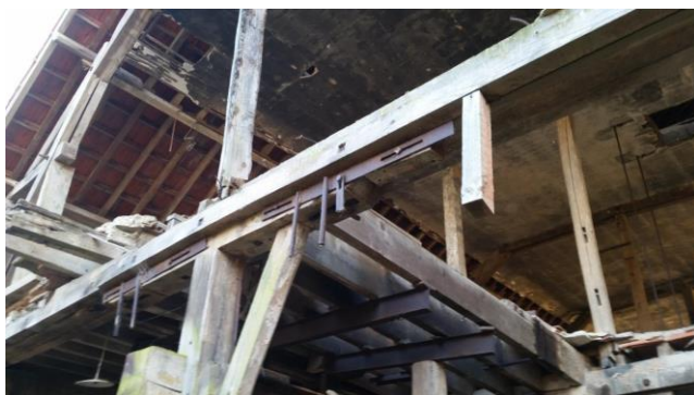
Plancher haut du rez-de-chaussée (Source : BETOM, mars 2015)
