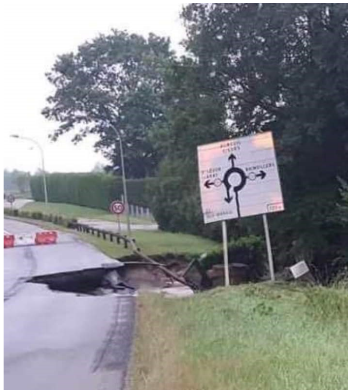
Route départementale Saint Léger en Bray
